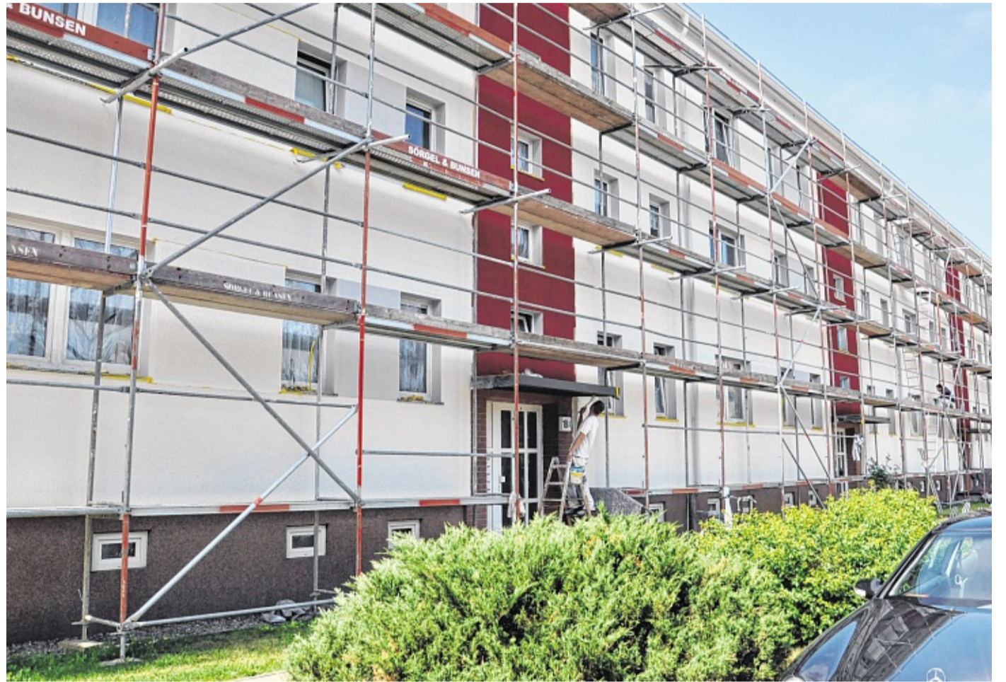
Noch komplett eingerüstet ist die Lassahner Straße 18: Hier gibts einen neuen Farbanstrich. FOTOS: SABRINA PANKNIN / MICHAEL SEIFERT
